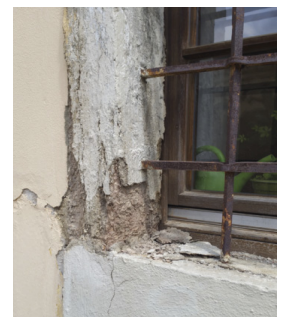
Gefügeeinfestigung
