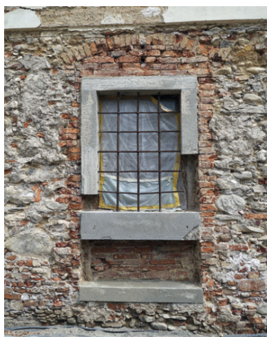
Festigung der Gewände, Vorbereitung zur Ergänzung mit Kalkstein
