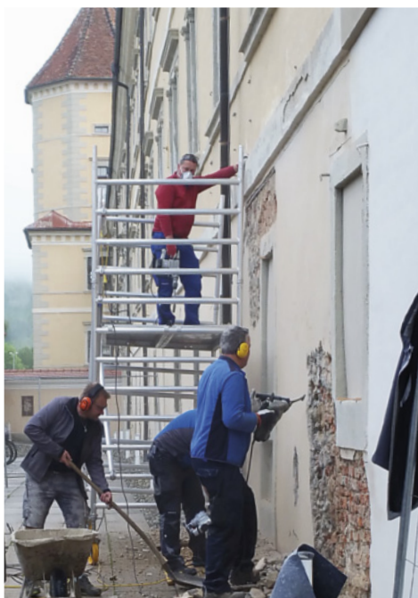
Start der Sanierungsarbeiten an der Westfassade
