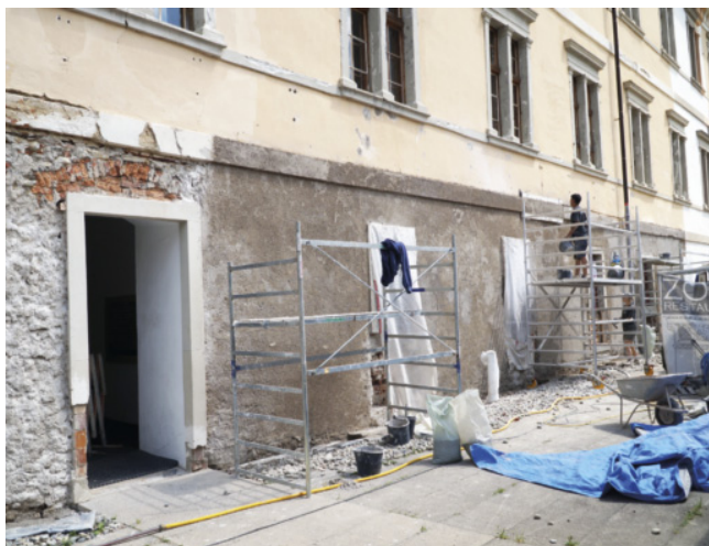
Sanierungsarbeiten an der Westfassade zwischen den Haupteingängen
